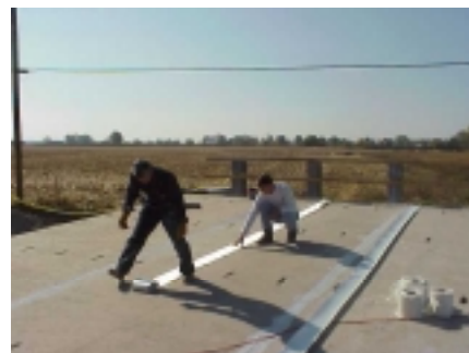
(d) FRP splice strips installed
